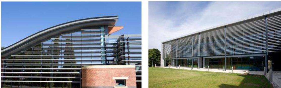
Il vantaggio dei sistemi fissi è la loro robustezza e l'assenza di elementi meccanici; quindi non hanno bisogno di molta manutenzione. Lo svantaggio consiste invece nel fatto che non sono adattabili alle variazioni della posizione del sole.
