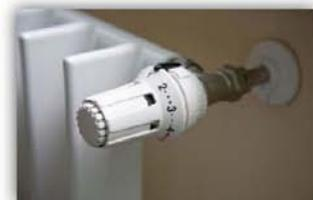
Se, in un impianto centralizzato, si dota ogni radiatore delle apposite **valvole termostatiche** per regolare la temperatura stanza per stanza e l'impianto è fornito di **contabilizzatore di calore**, si può avere una diminuzione dei consumi anche del 20%.
